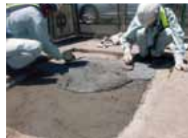
プライマー塗布後、ゴムラテモルタルをコテ塗り
